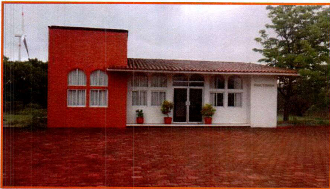
Figura 1.2. Edificio de Rectoría, Campus Juchitán
